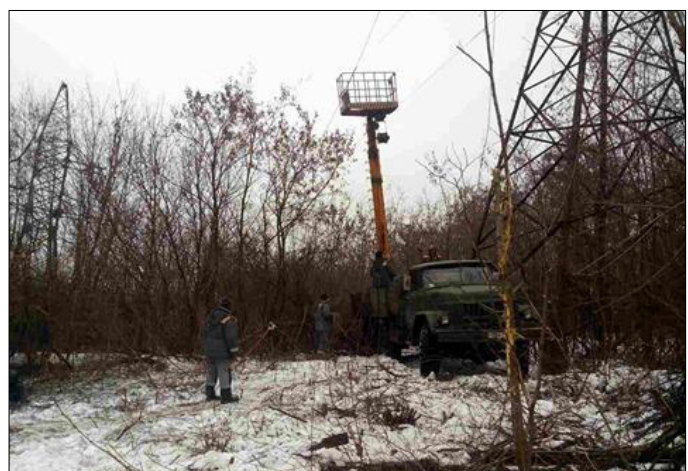
Ремонтні роботи на ЛЕП, пошкодженої обстрілами, 02.02.2017. Фото Державна служба України з надзвичайних ситуацій (ДСНС)
