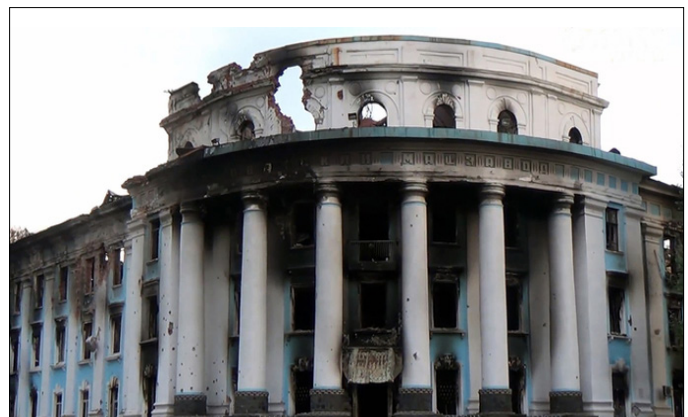
Будівля Ясинуватського машино-будівного заводу, зруйнована обстрілами, 22.09.2014. Фото DenTV
