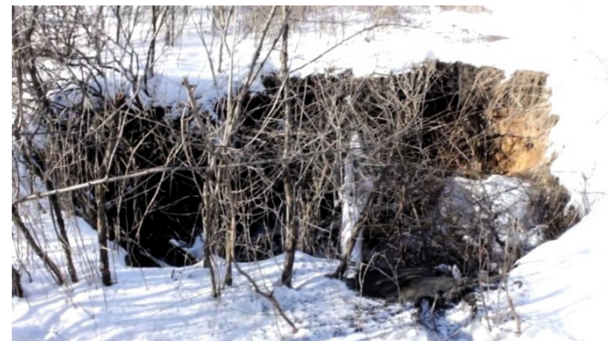
Зсув ґрунту поряд з шахтою Фото ACTED
