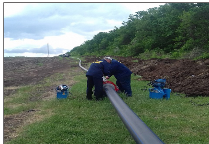
Ремонтні роботи системи водопостачання у Волноваському районі, 31.07.2020. Фото КП "Вода Донбасу".
