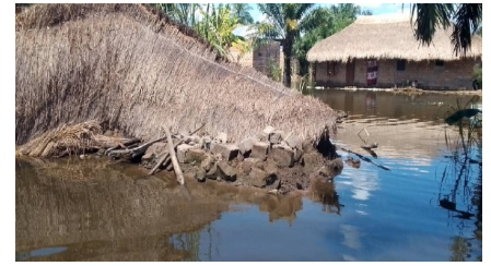
Abri affecté au bloc Janja (05/14/2026)
