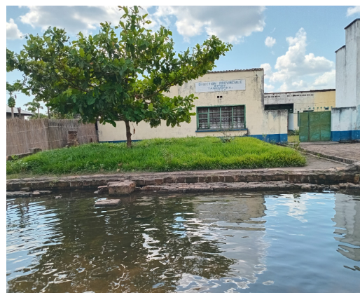
Les eaux de crue entourent le bureau de l'EPST (05/15/2026)
