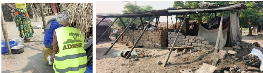
Collecte de données et observations de terrain menées par ADSSE afin de documenter les impacts des inondations et le contexte local (Kongolo, juillet 2026)
