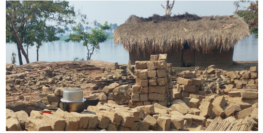
Habitation riveraine endommagée par les inondations, avec des briques en adobe récupérées pour la reconstruction (bloc Kalenga-Mayi, 07/04/2026)
