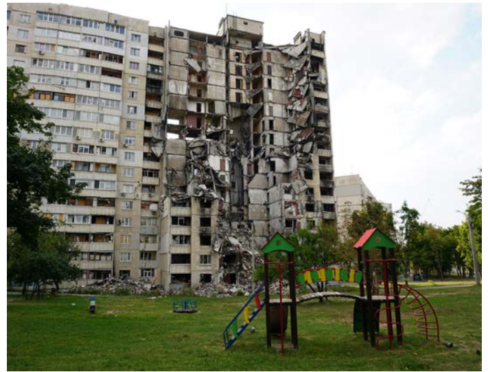
Рис. 3. Пошкодження житлової забудови у Салтівському районі
