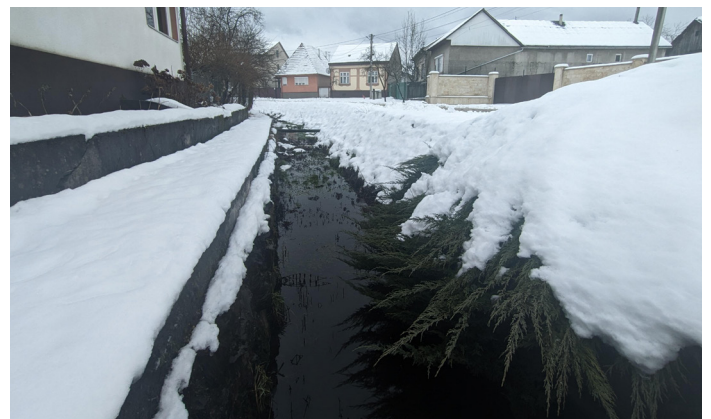
Зображення 2. Водовідвідний канал у м. Тячів.
